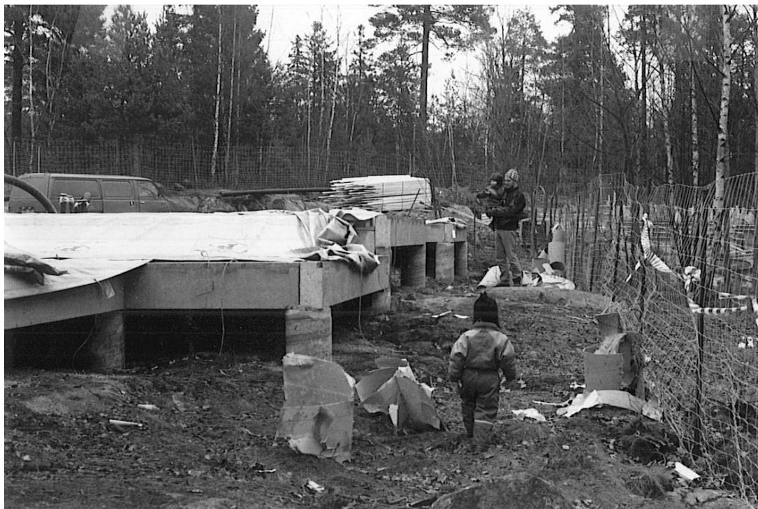
Figur 1. Foto från byggandet av Understenshöjdens BRF. Foto: Anna-Lena Larsson
