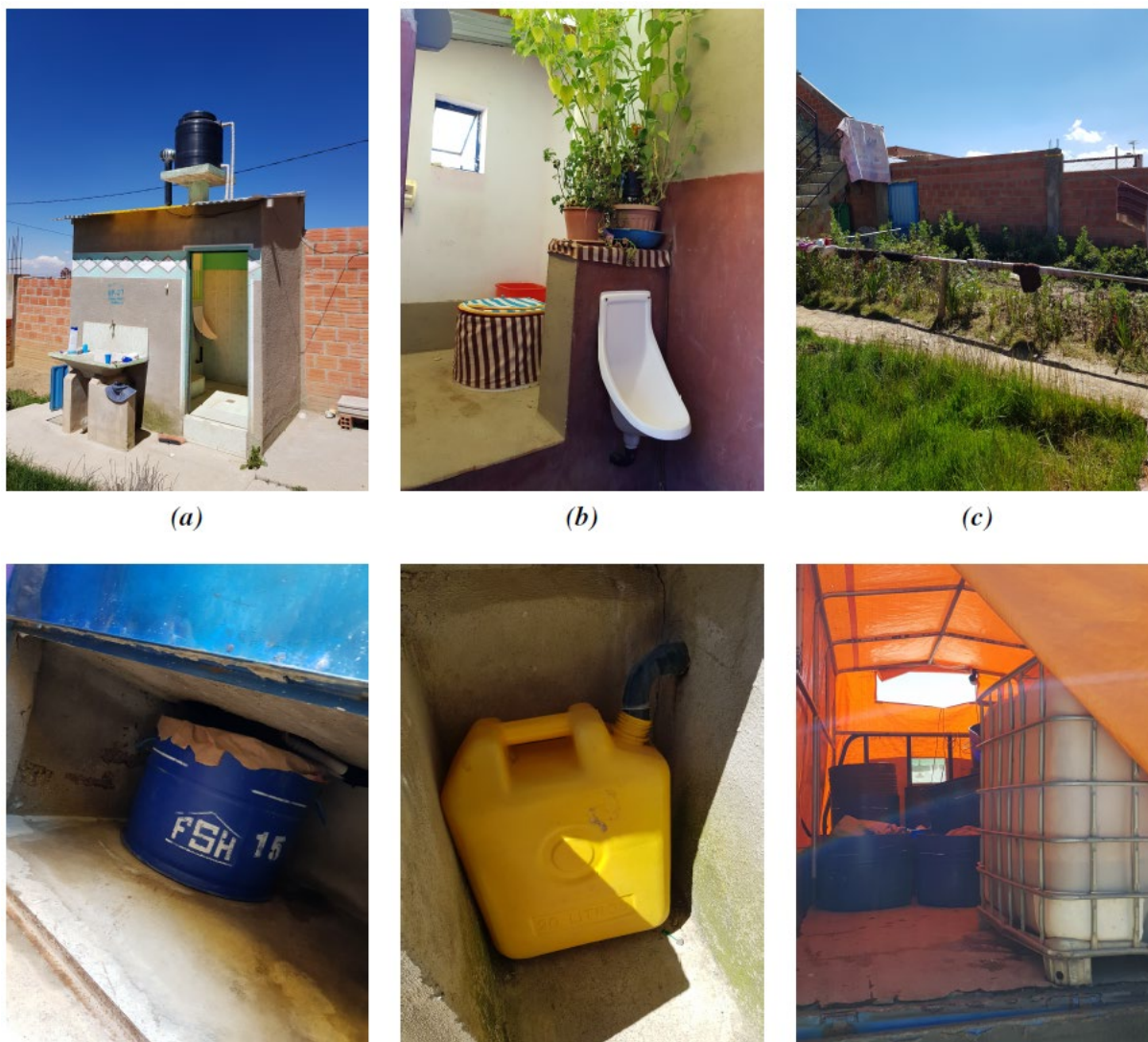
Figur 13: Torra urinsorterande toaletter och insamlingssystem i El Alto, Bolivia. Foton: Malin Smith 57
